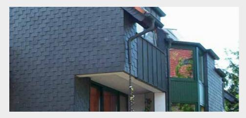
Die Gezogene Deckung erfolgt mit rechteckigen oder quadratischen Schiefern, wobei vollkantige oder eckengestutzte Steine möglich sind. Die Schiefer werden mit Höhen- und Seitenüberdeckung auf Vollschalung, Lattung oder Metallprofilen verlegt. Die Befestigung erfolgt laut nachstehender Tabelle mit Schiefernägeln oder -stiften, Klammer- oder Einschlaghaken, bzw. Einhanghaken bei Metallprofilen.
